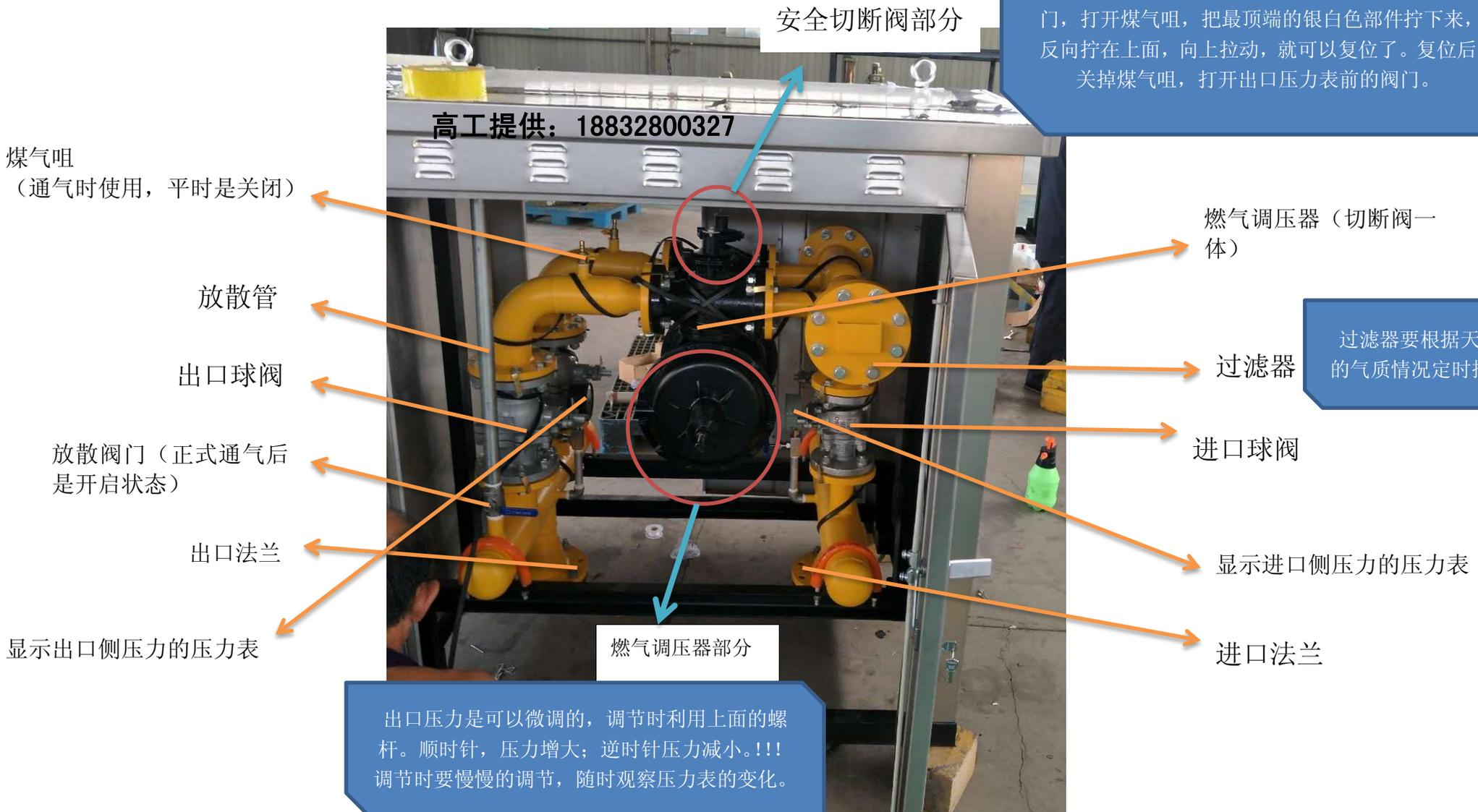
压力超过设定的安全压力以后,安全切断阀就会动作,切断气源。排查原因后,把切断阀复位就可以了,复位时要关掉进出口球阀、出口压力表前的阀门,打开煤气咀,把最顶端的银白色部件拧下来,反向拧在上面,向上拉动,就可以复位了。复位后关掉煤气咀,打开出口压力表前的阀门。
